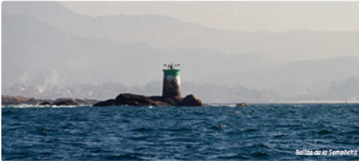
Canal Principal, entre Serralleiras y Silleiro. Canal da Porta entre Estela de tierra y Monteferro. Canal de Carracuido entre Estela de mar y Serralleiras.
