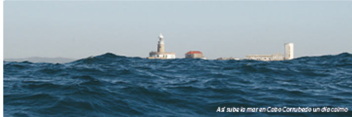
Así sube la mar en Cabo Corrubedo un día calmo
